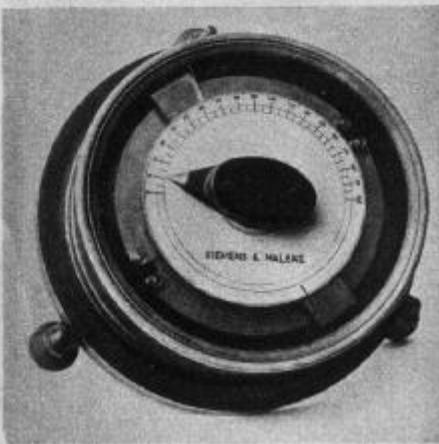
Abb. 27c Erster Drehkondensator nach Dr. Koepsel, im Jahre 1901 von Siemens & Halske, Berlin, gebaut. Der Apparat, welcher 600 000 000 Nachfolger in kaum 20 Jahren gefunden hat!
