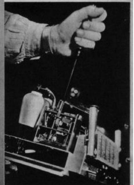
Abb. 232 Feineinstellung der Zwischenfrequenz
